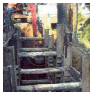
Escoramento de vala
