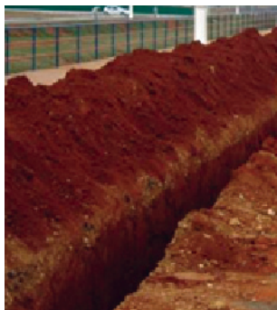
Abertura de vala
