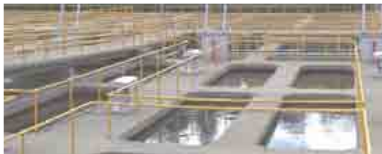
Floculador mecanizado
