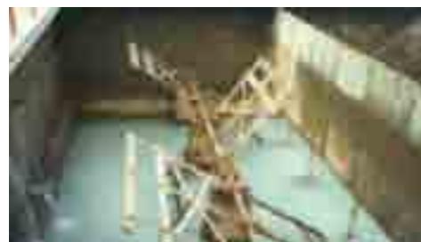
Floculador mecanizado com pás horizontais
