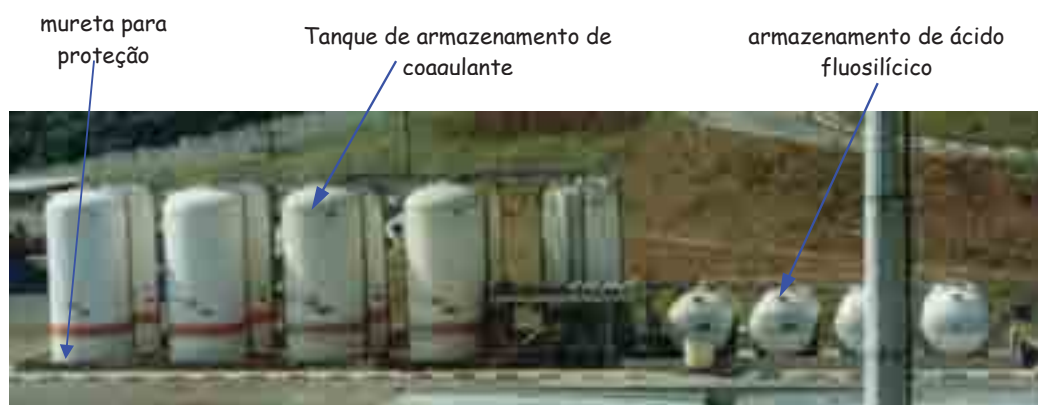
Tanques de armazenamento de solução e cilindro para armazenamento do ácido fluossilícico na ETA.
