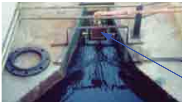
Misturador hidráulico – medidor Parshall
