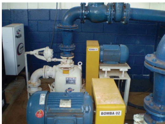
Conjuntos moto-bomba e quadro de comando em EEE
