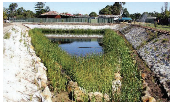
Sistema de terras úmidas
